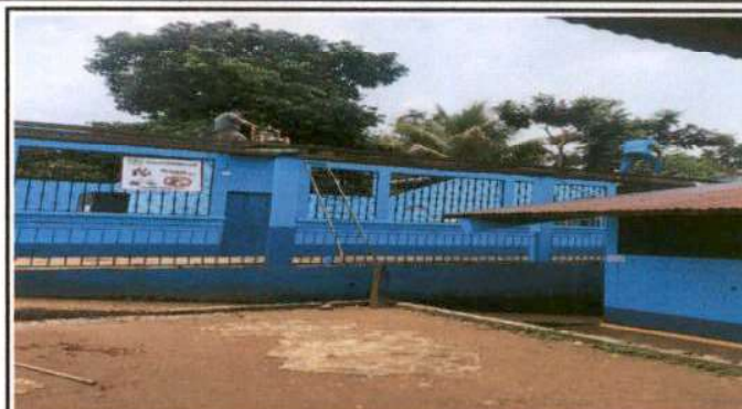
Foto2: MÓDULO 1 AULAS CAMBIO DE LÁMINA, POR LÁMINA ACANALADA ALUZINC CALIBRE 26
