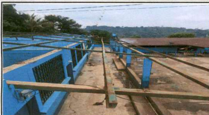
Foto1: MÓDULO 1 AULAS CAMBIO DE LÁMINA, POR LÁMINA ACANALADA ALUZINC CALIBRE 26
