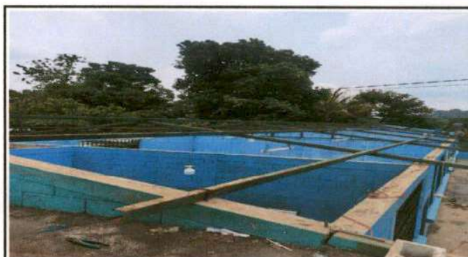
Foto 4: MÓDULO 1 AULAS MANTENIMIENTO A ESTRUCTURA DE SOPORTE DE METAL
